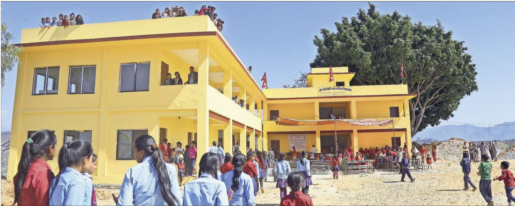
Mit finanzieller Unterstützung aus Bühl: Der erste Bauabschnitt für die neue Schule von Thulosirubari (Nepal) ist beendet. Fotos: Milan Shrestha/Nepalhilfe Beilngries
